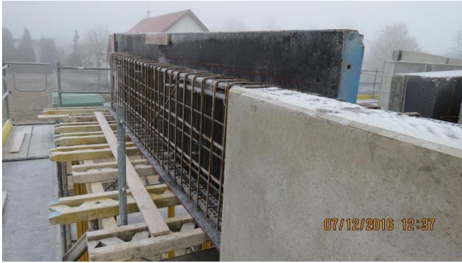
Bewehrung des Stahlbetonträgers
