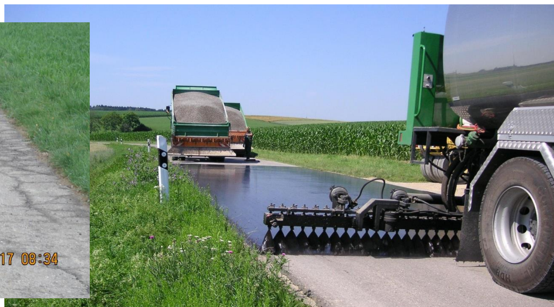
Sanierungsart mit Bitumenemulsion und anschließender Splittabstreuung
